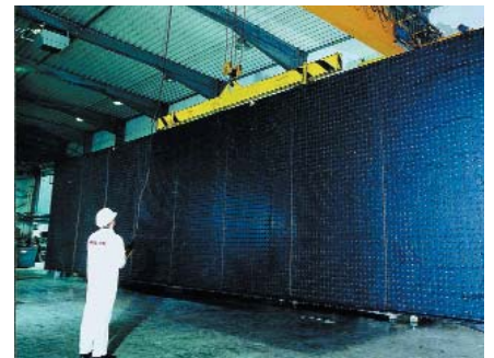
Mit einer werkseitig vorgefertigten Bekaplast™-Tauchwanne mit über 100 m³ Inhalt wird eine Salzsäurebeizanlage zeitsparend saniert.
